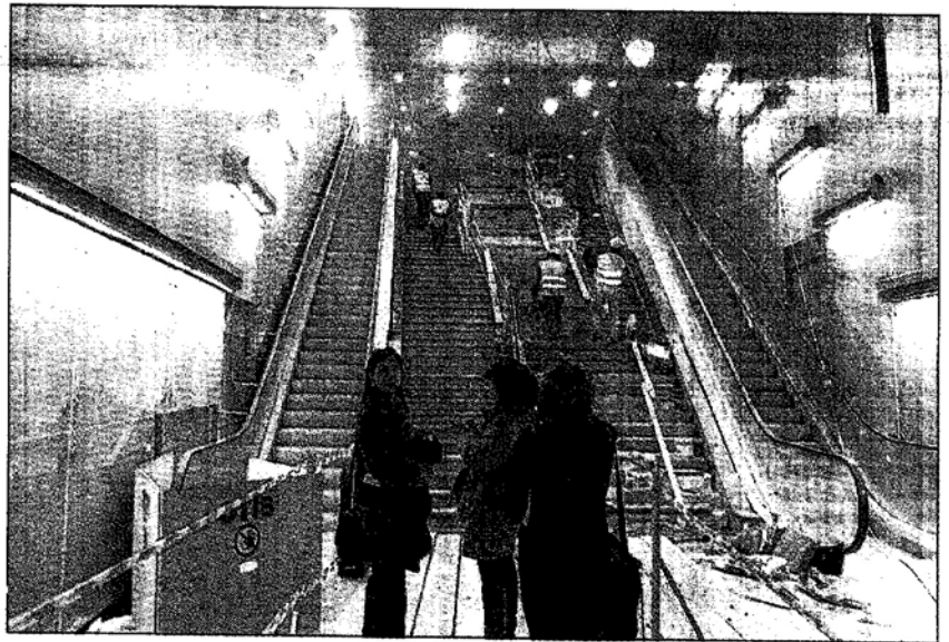
La scalinata che conduce all'atrio della stazione del metrò di piazza De Ferrari
