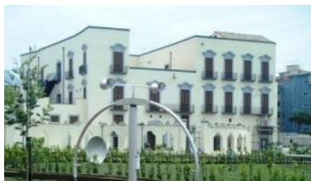
Villa Mascolo, sede dell'intervento di Bianco-Valente
